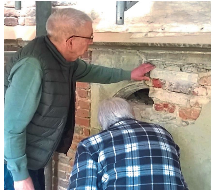
Bauleiter Hille und Herr Krupa von der Firma Eichholz..
